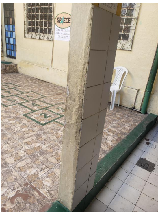
Imagem 02 – Foto tirada in loco do pátio da escola. Fonte: COINF-SME.
