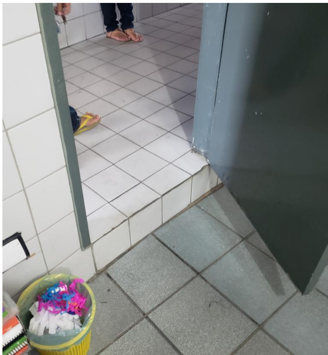
Imagem 03 – Foto tirada in loco da sala de aula da escola. Fonte: COINF-SME.
