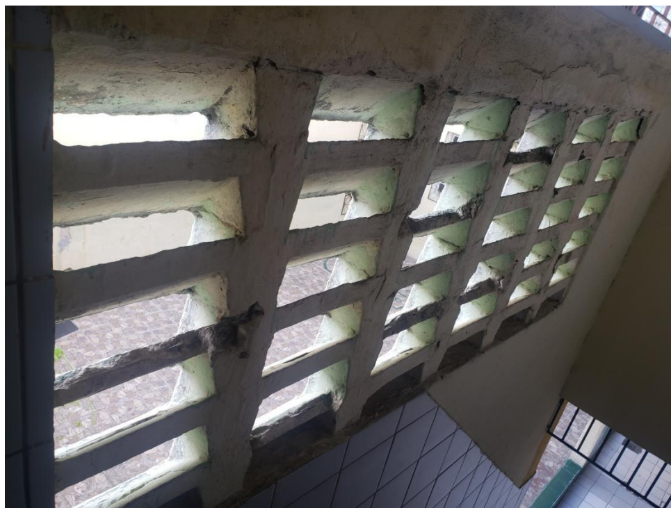
Imagem 21 – Foto tirada in loco dos cobogós das salas de aula. Fonte: COINF-SME
